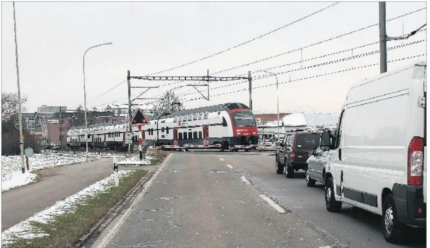
Normalzustand am Bahnübergang in Werrikon: wartende Autos vor der mehrheitlich geschlossenen Barriere. (brü)
