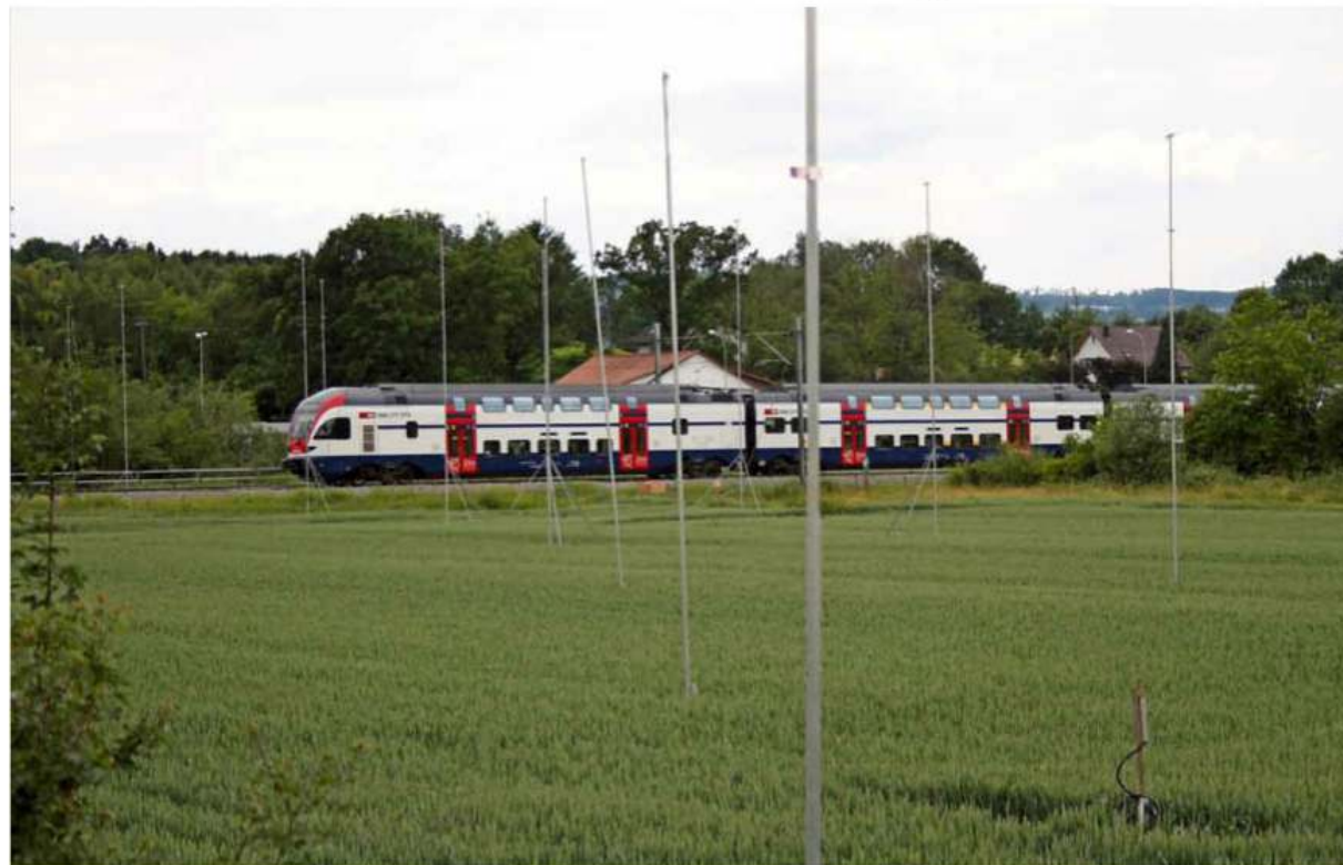
Im besten Fall beginnt der Kanton im Jahr 2015 mit dem Bau der Strasse Uster West. Im Bild das Baugespann für die Überführung über die Bahnlinie. Bild: Eduard Gautschi
