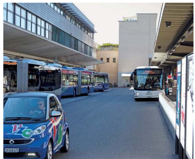
Abbildung 56: Der Bushof aus den 1990er-Jahren gelangt an seine Kapazitätsgrenzen. Schon heute sind nicht genügend Anlagekanten vorhanden, sodass Busse auch neben dem Perron für Pausenzwecke halten. Quelle: Hoffmanns Bilder 2017.
